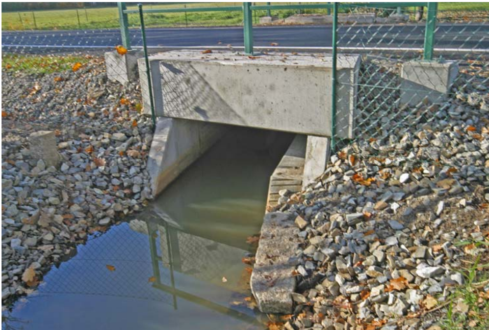
Durchlass an der K 8473 bei Mönau
