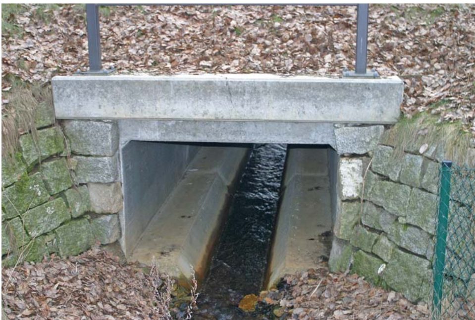
Durchlass an der K 8471 bei Förstgen
