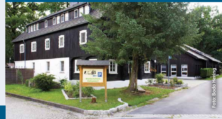
Das Waldschulheim soll künftig besser vor Hochwasser geschützt sein.
